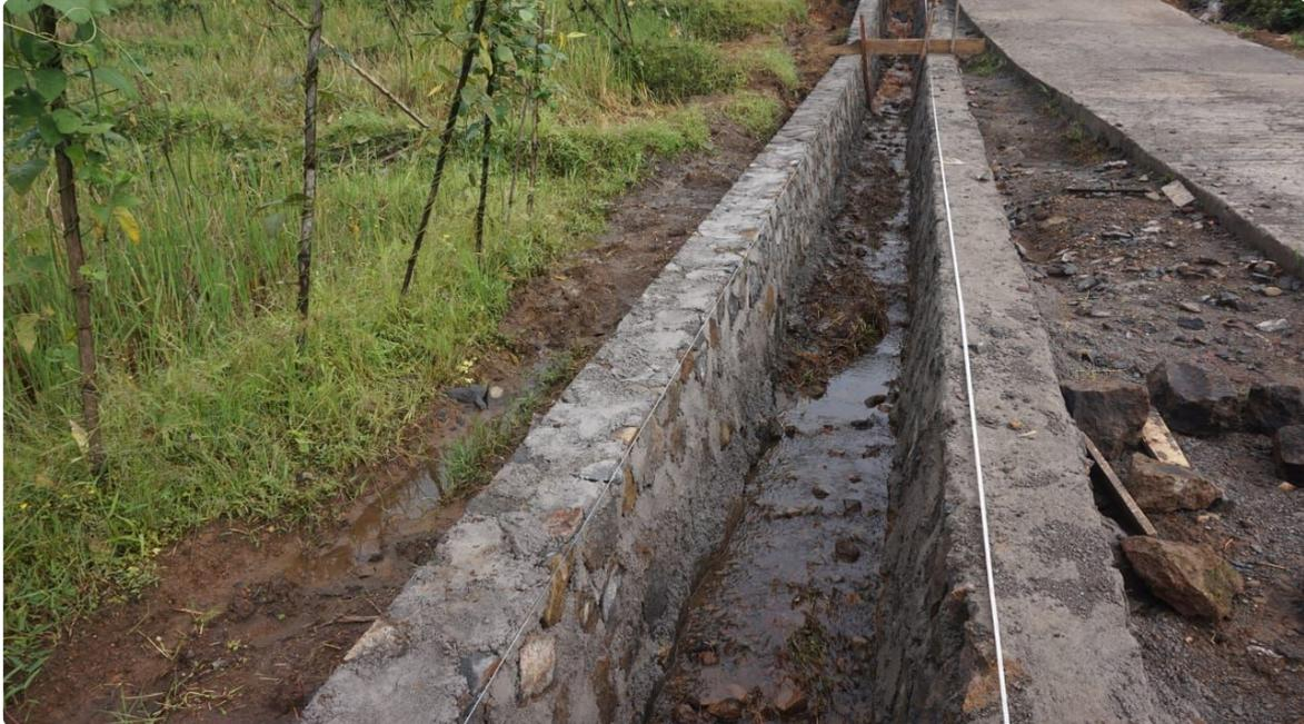
"Setelah kami menyelesaikan pengerjaan cor beton jalan, kami langsung melanjutkan dengan pengerjaan irigasi. Saat ini, hasil pengerjaan irigasi sudah mulai tampak dan berjalan dengan baik. Adapun volumenya adalah panjang 71 meter, lebar 0,80 meter dan tinggi 1 meter" ujar Letda Inf Dremo.
